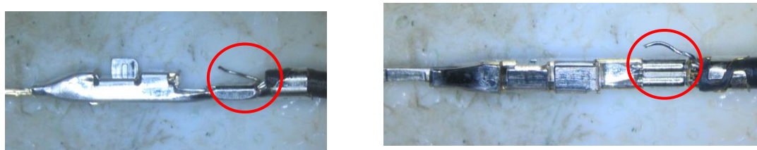
図 20.芯線はみ出し状態
